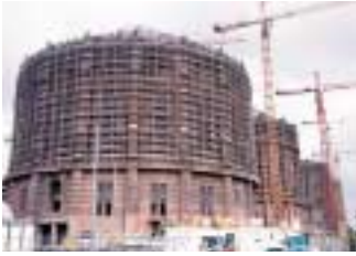
In den Zylindern des größten Gasometerkomplexes Europas entstehen Hochhäuser.
